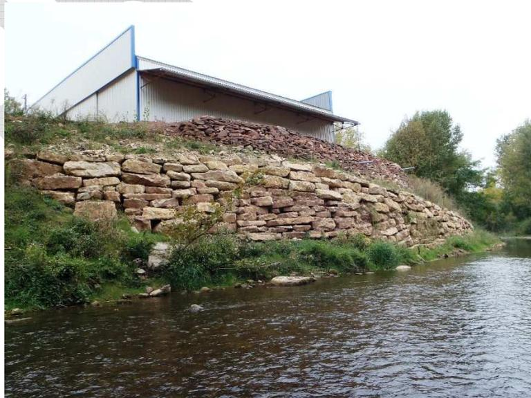
*Figure 10 : Protections de berges par enrochement, Saint-Affrique*
